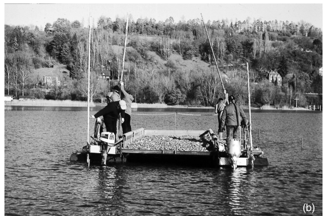
Abb. 2: Erosionsschutz bei freigelegten jungsteinzeitlichen und bronzezeitlichen Kulturschichten in der Flachwasserzone des Bodensees: (a) Taucher bei der Kontrolle der ausgelegten Geotextilmatten, (b) speziell konstruierte Klappschute zum zielgenauen Aufbringen der Kiesschüttung (Fotos: J. Köninger, terramare – Archäologische Dienstleistungen, Freiburg i.Br.)
