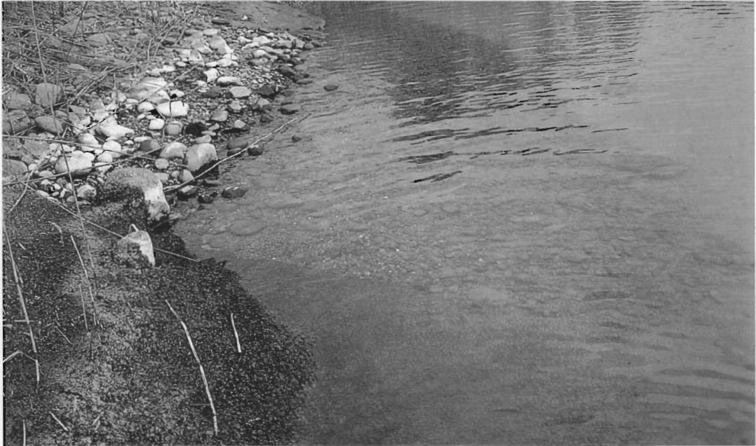
Abbildung 3. Uferabschnitt im Untersuchungsgebiet mit Enkamat®-Matten (Vordergrund, Variante „Geotextil-Kies“) und Kies-Schüttung (Hintergrund, Variante „Kies-Substrat ohne Abdeckung“) (Foto am 13.3.1995, Pegel Konstanz 3,01 m).
