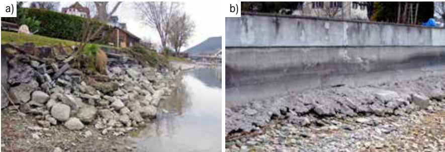
Abbildung 7: Entwicklung von Uferverschüttungen und Ufermauern: Im ersten Schritt wird das Ufer mit Bauschutt o. ä. aufgefüllt (a) Stein am Rhein, Foto: 26.03.2011, später wird das Schüttungsmaterial mit Beton vergossen, sodass es als Fundament für die aufgehende Mauer dienen kann (b) Berlingen, Foto: 13.03.2011.
