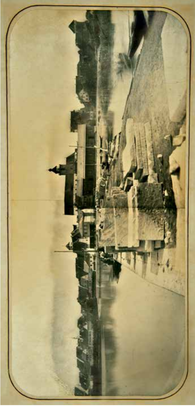
Abbildung 5: Aufschüttung der Radolfzeller Schiffsände nach dem Bau des Bahnhofs und Befestigung mit Sandsteinblöcken um 1866 \pm 3 Jahre; am linken Bildrand ist noch unaufgeschüttetes Ufer zu erkennen, am rechten Bildrand des Rest eines teilweise überschütteten Schiffbestands; das in Panorama-Technik aufgenommene Foto ist wahrscheinlich die älteste Darstellung von Uferbefestigungen am Bodensee (mit freundlicher Genehmigung des Stadtarchivs Radolfzell).
