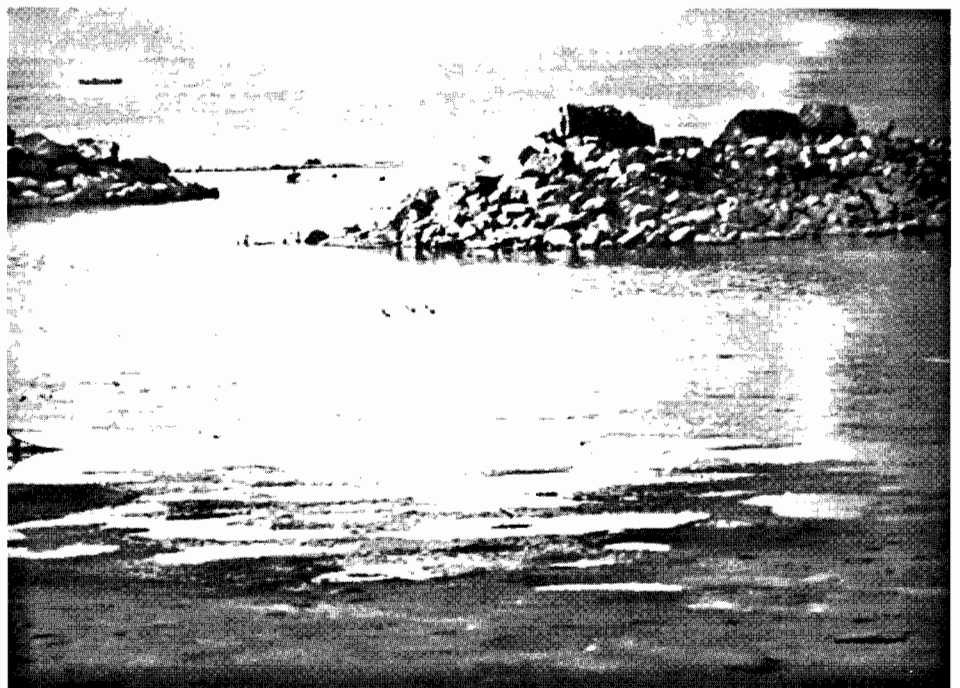
Abb. 3: „Harter“ Uferschutz an der Bregenzer Aach-Mündung am Bodensee-Obersee (Österreich): Schüttsteinwälle von 12,7 m Breite und 2,5 m Höhe, Dammkrone 1,5 m über dem mittleren Jahreshochwasserniveau. Foto: W. Ostendorp
