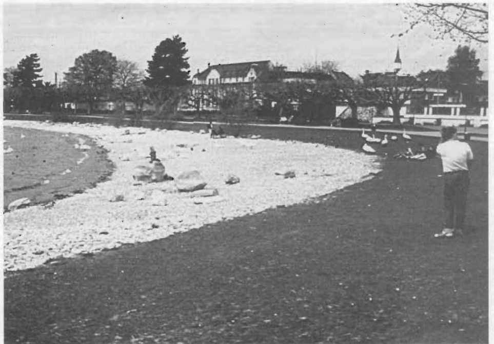
Abb. 6: „Uferverschönerung“ bei Radolfzell am Bodensee-Untersee mit geringem ökologischen Wert: Hier wurde eine Steinmauer durch Wacken-Vorschüttungen abgedeckt; gleichzeitig wurde durch Anlage von Uferpromenade, Liegewiese und Hafencafé der Besucherverkehr intensiviert. Foto: W. Ostendorf
