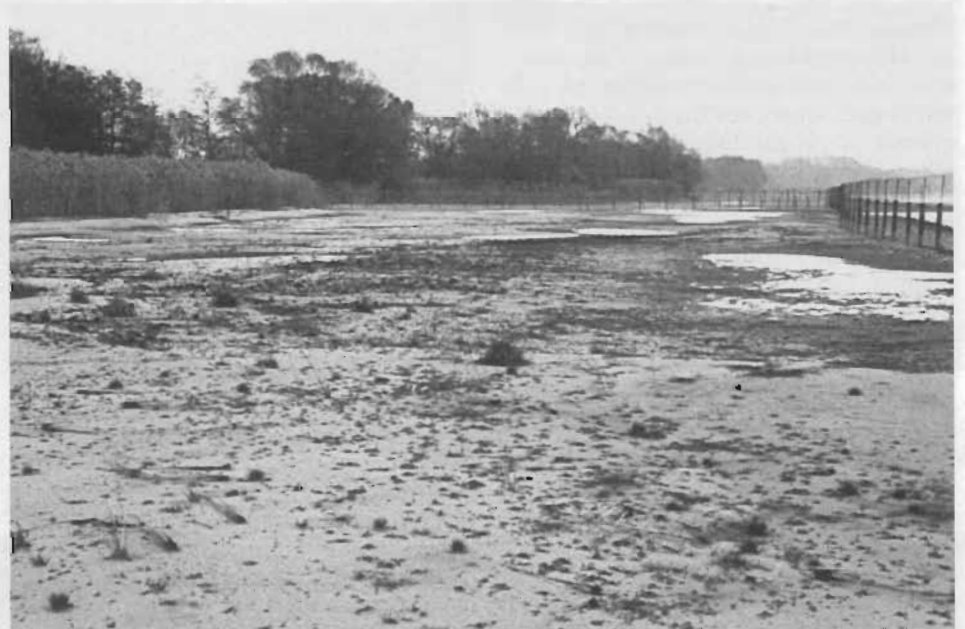
Abb. 5: Uferrenaturierung an der Lipbach-Mündung (bei Friedrichshafen) am Bodensee-Nordufer: Durch Aufspülen von Deltsanden wurde das ursprüngliche Niveau vor der Klifferosion wiederhergestellt. Ein niedriger Wackendamm gibt der Spülfläche die seeseitige Stabilität. Inzwischen ist der größte Teil der Spülfläche von Röhrichtvegetation überwachsen und so (zunächst) vor Erosion geschützt.
