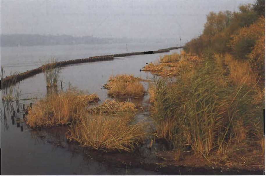
Abb. 27. Uferschutzmaßnahmen an der Havel (Berlin): links sichelförmige Reihen von Lahnungen (Doppelpfahlreihen mit gestopftem Totastholz) zur Wellendämpfung, im Vordergrund Schilf- und Rohrkolbenpflanzungen. – Foto W. OSTENDORP.
