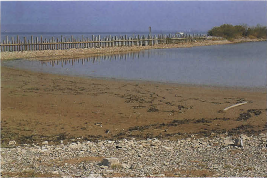
Abb. 30. Wellenbrecherwall mit Palisadenreihe am Rohrspitz (Bodensee-Obersee, Vorarlberg), im Vordergrund Faulschlamm-Anschwemmungen im Strömungsschatten der Wellenbrecheranlage. – Foto W. OSTENDORF.
