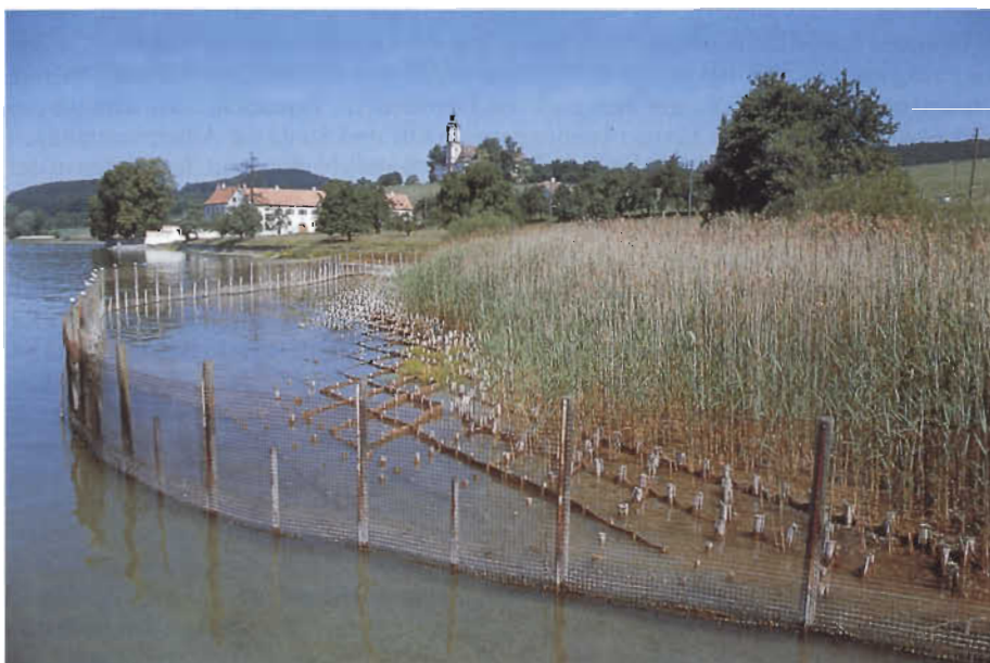
Abb. 28 und 29. Sedimentfangkassetten der Renaturierungsfläche Obermaurach (Bodensee-Obersee, Bodenseekreis) mit Treibgut-Schutzzaun; im Hintergrund rechts natürlicher Schilf-Restbestand. Oben: nach Fertigstellung der Kassetten [April 1988]; unten: zu Beginn der sommerlichen Überschwemmungsperiode [Juni 1991]. – Fotos W. OSTENDORP.
