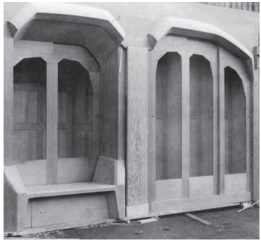
Anbau Haus Brodbeck. Eine Aufnahme aus der Zeit der Herstellung
