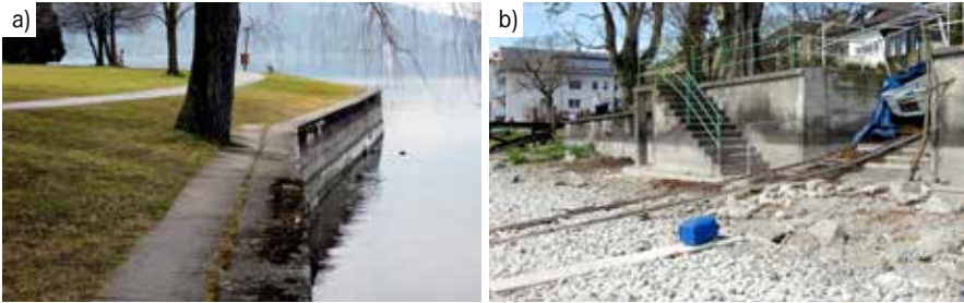
Abbildung 3: Ufermauern am Bodensee-Untersee – Szenario C: (a) langgestreckte, knapp 3 m hohe Gussbetonmauer westlich Steckborn/Ortsteil Fäldmeilen mit hinterliegendem Uferpark (Foto: 15.03.2011, W. Ostendorf); (b) Ufermauern mit landseitigen Wohngebäuden und intensiver seeseitiger Nutzung am Südufer der Insel Reichenau/Ortsteil Mittelzell (Foto: 03.04.2011, W. Ostendorf).
