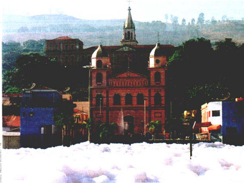
Abwasserrückstände in Pirapora: Kloake mitten in der Stadt
