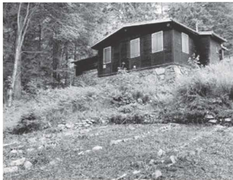
Abb. 13: Die noch stehende Baracke Nr. 17 mit vorgelagerten Resten der vermuteten Waschbaracke Nr. 15 (Foto: B. Hausmair).
