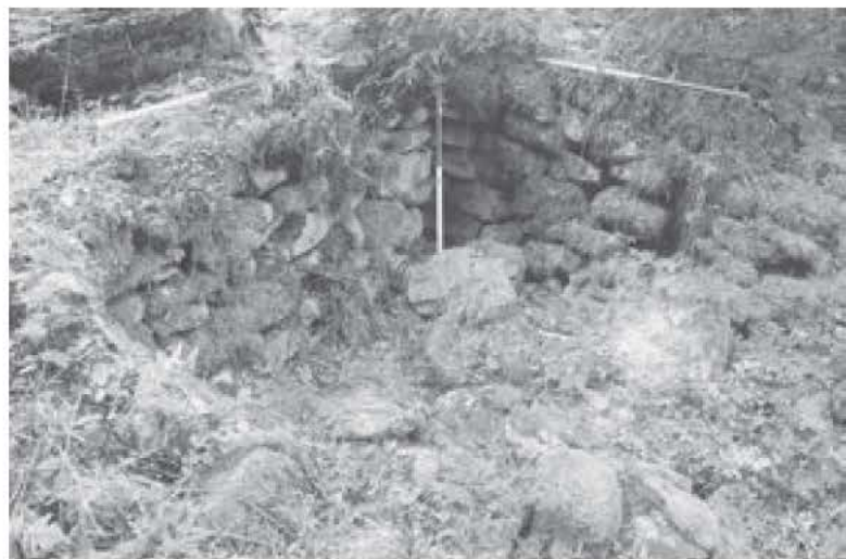
Abb. 15: In den Hang gebaute Mauern des Gebäudes Nr. 11 (Foto: B. Hausmair).
