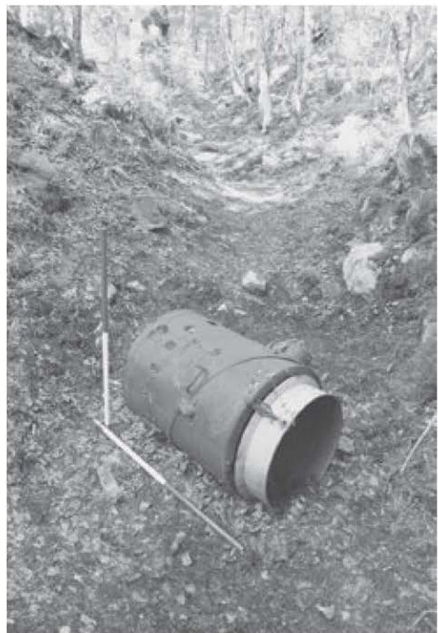
Abb. 18: Reste eines Heizkessels (Foto: I. Greußing).
