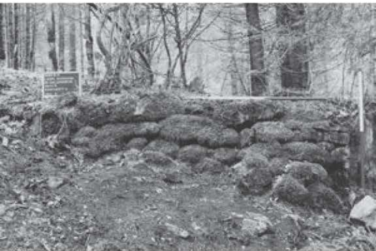
Abb. 10: Terrassenmauer (Nr. 9) (Foto: V. Appel).
