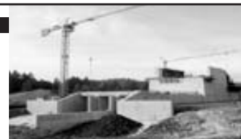
Bild: Auslaufbauwerk Hochwasserrückhaltebecken Wolterdingen
