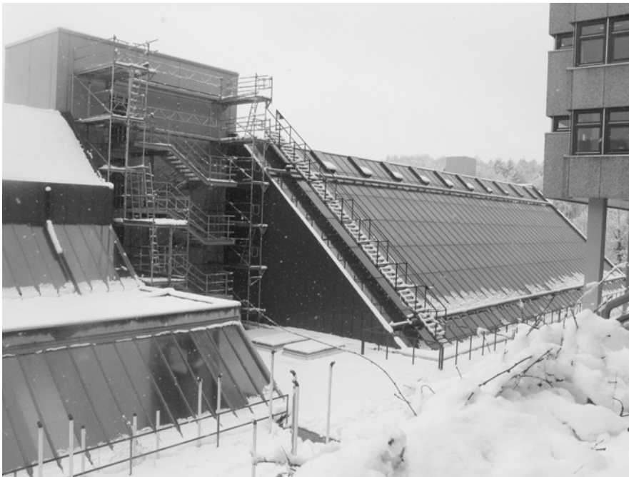
Das sechsstöckige Gebäude verjüngt sich nach oben hin entsprechend der Neigung des nach Norden liegenden schrägen Glasdaches.
