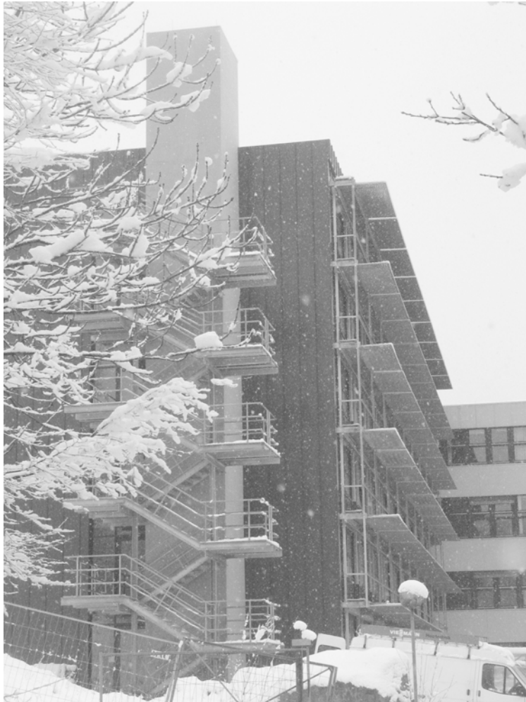
Außentreppe für Notfälle an der Westseite des Anbaus
