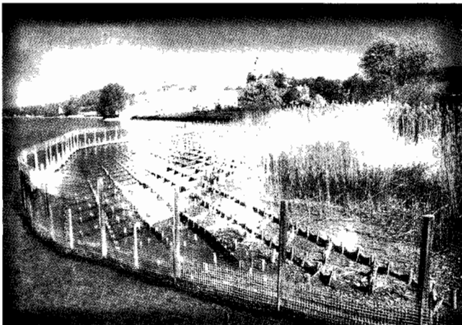
Bild 6. Renaturierungsfläche Obermaurach – Variante B: Sedimentationskassetten.
