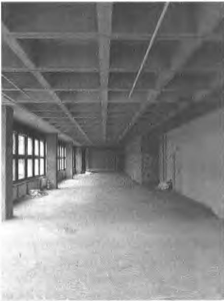
Abb. 2: Rohbauzustand nach Asbestrückbau (Foto: Michael Frank).
