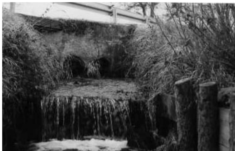
Bild 6: Die Verdohlung unterhalb des Mühlweihers an der Kreisstraße. Sie ist für Steinkrebse wohl nicht durchgängig
