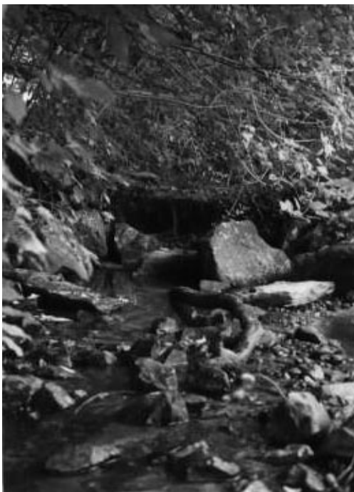
Bild 3: Kaltbrunn; im Hintergrund erkennt man den Querriegel aus Beton
